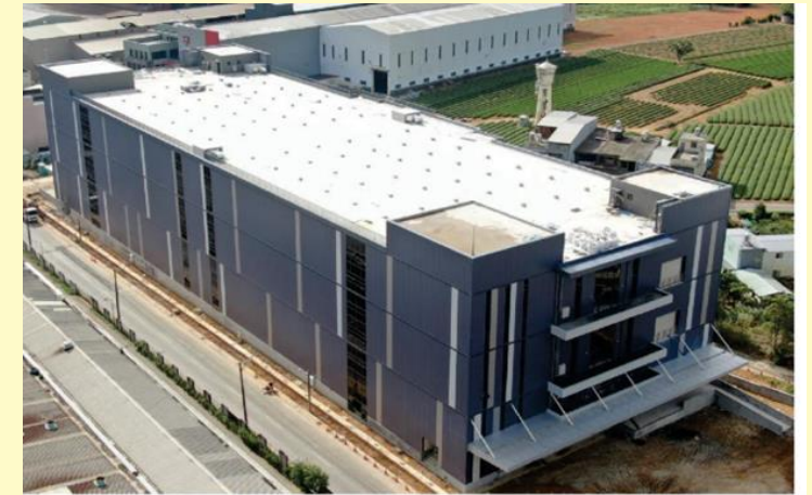
龍潭智能園區-A棟倉庫 倉庫面積：5,000坪
